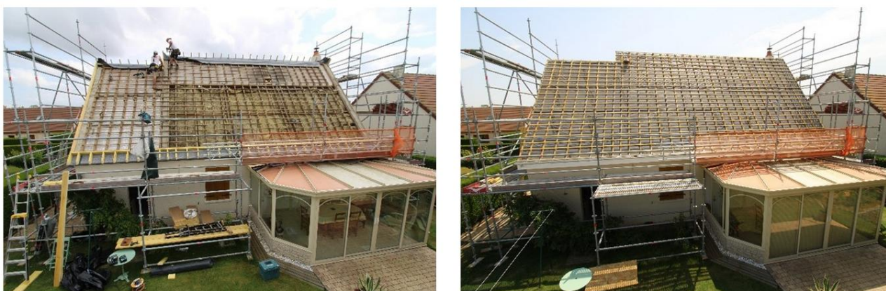
Figure 17 – Exemple de rénovation en Normandie avec la solution Baticok 1.
