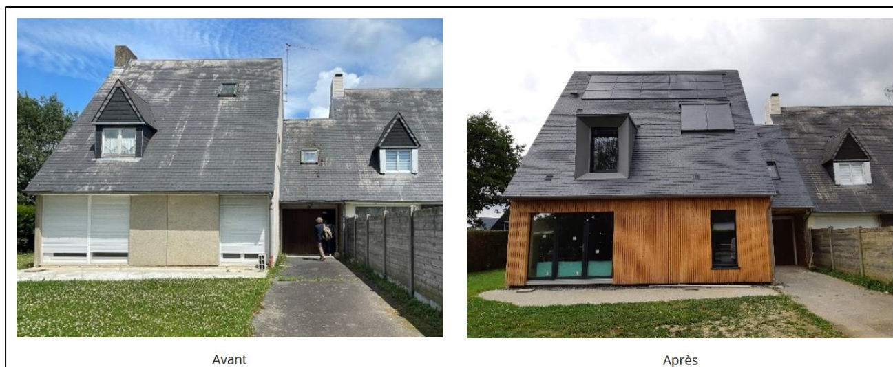
Figure 16 – Exemple de rénovation avec la solution Baticok2 en Normandie.
