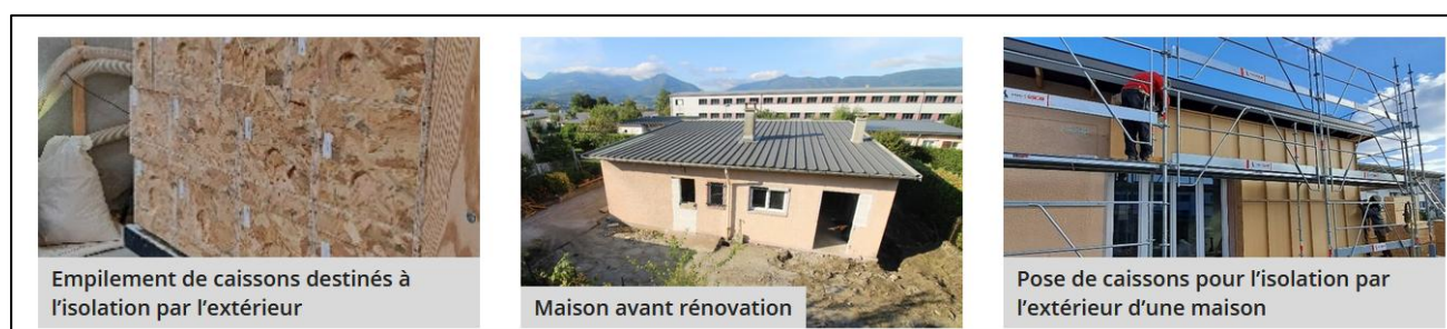
Figure 18 – Exemple de mise en œuvre des panneaux Blokiwood.
